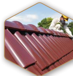
THI CÔNG DỄ DÀNG
